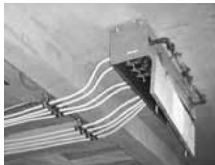
Рис. 9.32. Модульное размещение регулирующих клапанов [40]
