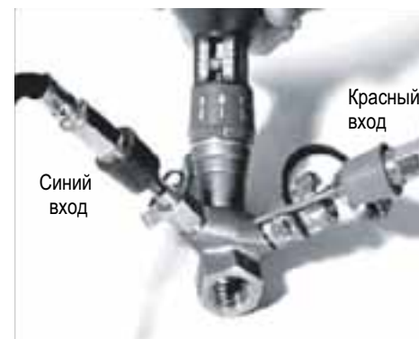
Рис. 10.4. Присоединение шлангов к клапану MSV-C
