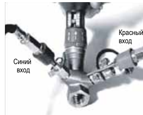
Рис. 10.4. Присоединение шлангов к клапану MSV-C
