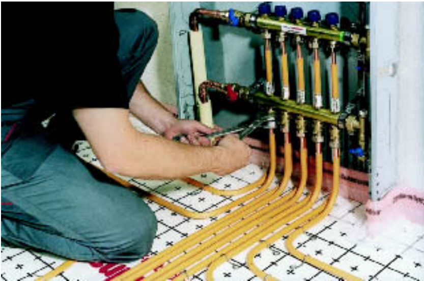
Рис. 4.46 Подключение труб к распределителю при помощи двух ключей
