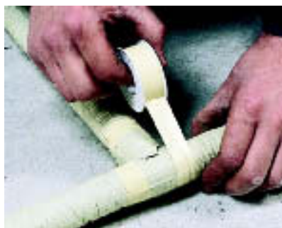
Рис. 4.27 Место соединения обмотать коропластовой лентой
