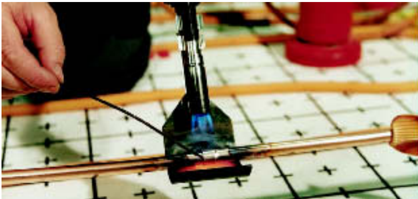
Рис. 4.45 Пайка твердым припоем: разогреть место соединения, и после достижения температуры пайки подвести припой. После испытания под давлением пластмассовую изоляцию надвинуть обратно, продольные и поперечные разрезы обернуть клейкой лентой из синтетического материала.
