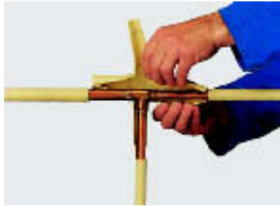
Рис. 4.24 слева: раскрой фасонной детали справа: накладка фасонной детали
