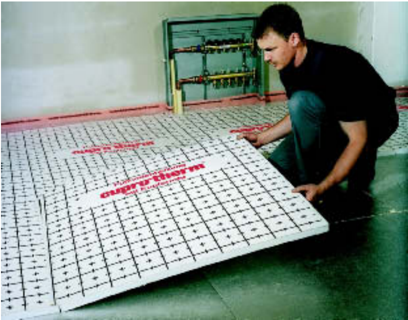
Рис. 4.41 Укладка по периметру пола изоляционных полос и настил системной изоляции cuprotherm®
