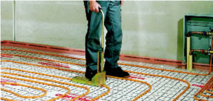
Рис. 4.44 Крепление нагревательной трубы двойными скобами с использованием степлера (альтернатива: ручные скобы) с шагом около 1м, включая отдельное крепление радиусных участков в начале и конце дуги
