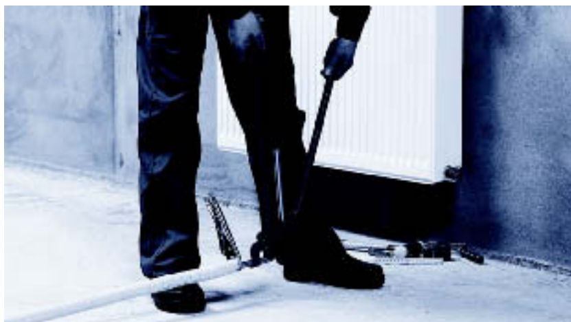
Рис. 4.35 Гибка трубы WICU®_flex с использованием инструмента
