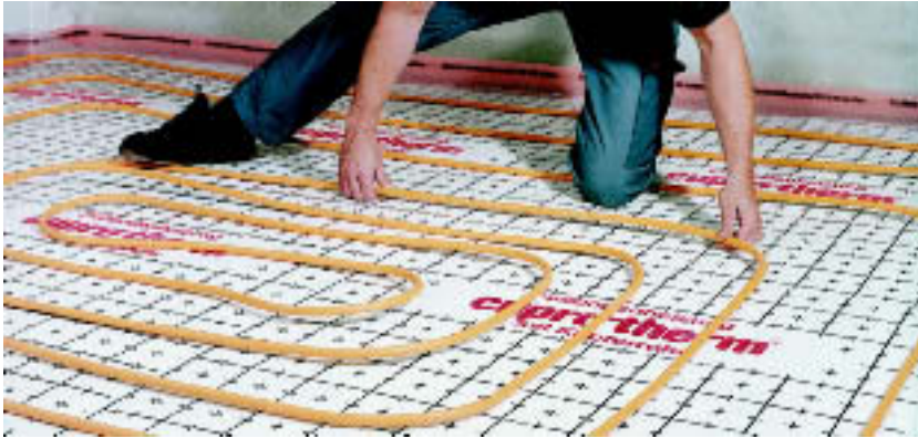
Рис. 4.43 Выравнивание труб в вертикальном и горизонтальном направлении таким образом, чтобы они ровно без изгибов лежали на полу
