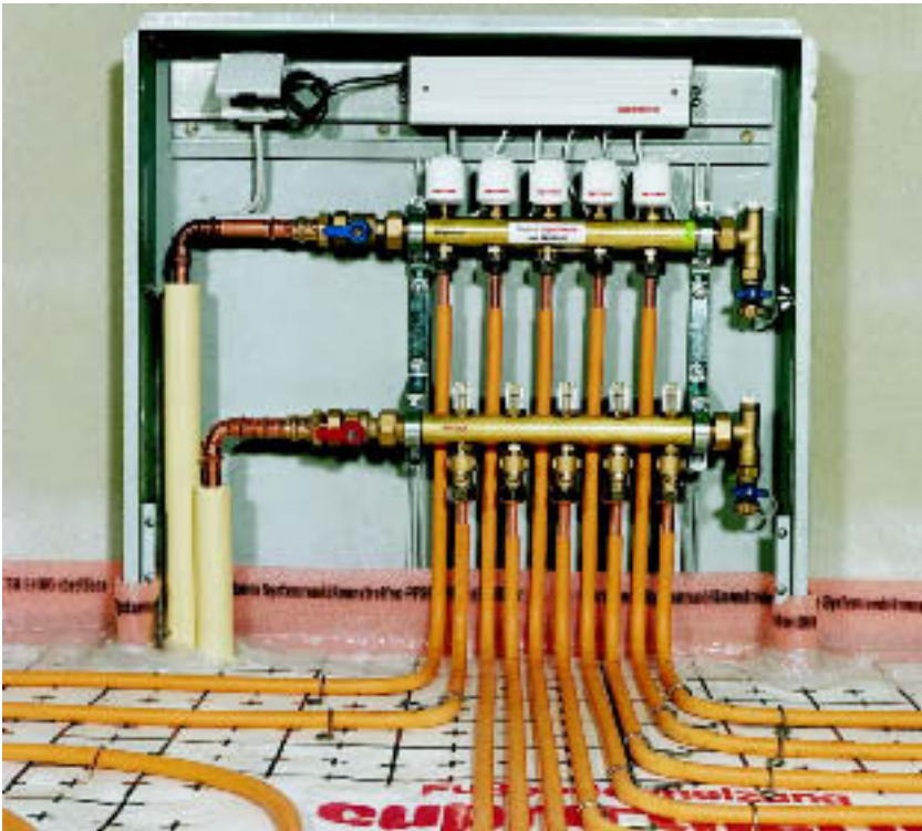
Рис. 4.47 Распределитель в сборе
