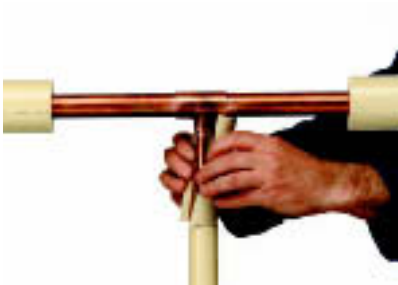
Рис. 4.32 слева: накладка короткого рукава справа: пробивание отверстия при помощи пробойника
