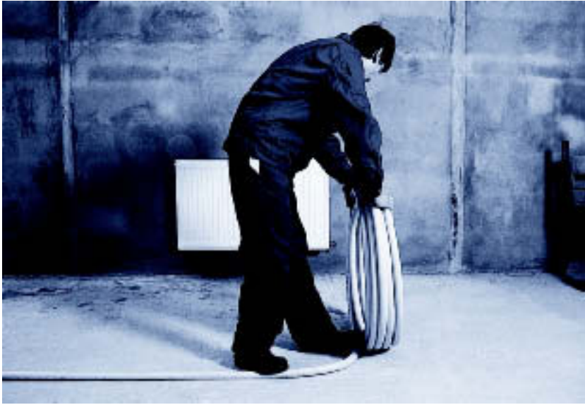
Рис. 4.34 Гибка трубы WICU®_flex без использования инструмента
