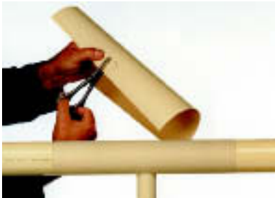
Рис. 4.33 слева: раскрой наружной изоляционной оболочки справа: накладка наружной изоляционной оболочки
