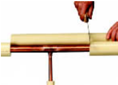
Рис. 4.31 Для изоляции тройниковых соединений диаметром свыше 28 мм используется рукав WICU®. На рисунках показан раскрой
