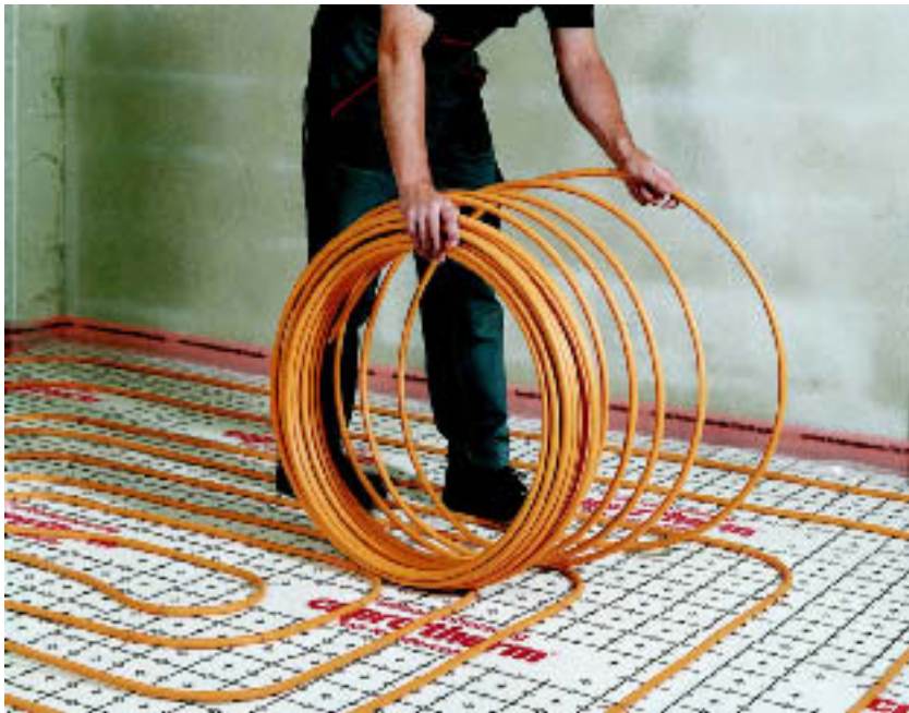
Рис. 4.42 Разматывание труб по разметке согласно плану прокладки
