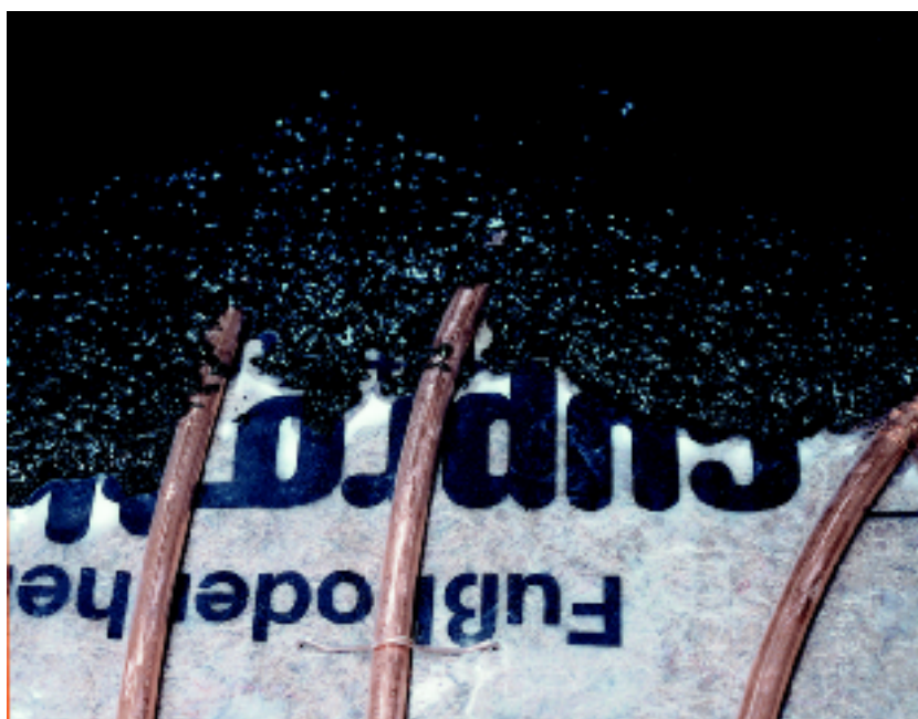
Рис. 3.10 Панельное отопление ® cuprotherm : прокладка труб в литом асфальте
