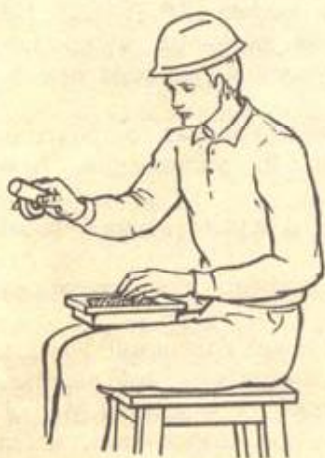
Рис. 168. Отеска изразца
