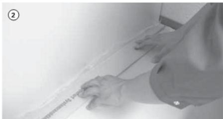
2. Укладка демпферной ленты Roth – удалить защитный слой с клеящей пленки ленты Roth 80 мм и приклеить ленту.
