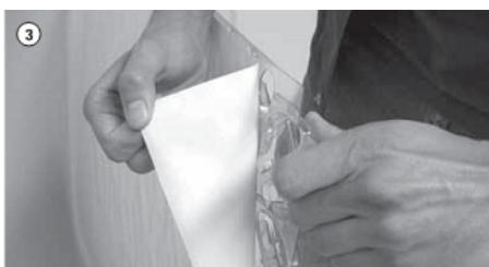
3. Приклеить системную плиту Roth ClimaComfort – удалить защитный слой с клеящей стороны и приклеить плиту в угол стены так, чтобы были доступны точки соединения.
