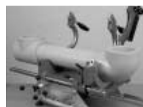
готовая сварка после охлаждения
