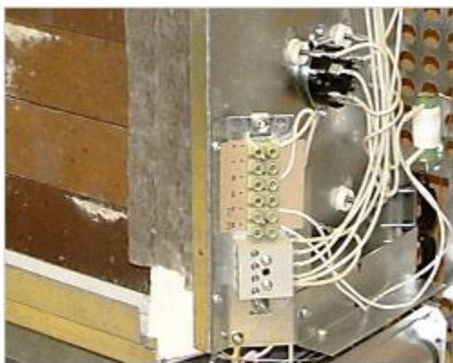
Теплоаккумулятор имеет стационарное подключение к сети 3х фазного тока напряжением 380 вольт (возможно подключение теплоаккумуляторов моделей ТН 2520, ТН 2530 к сети однофазного тока напряжением 220 вольт).
