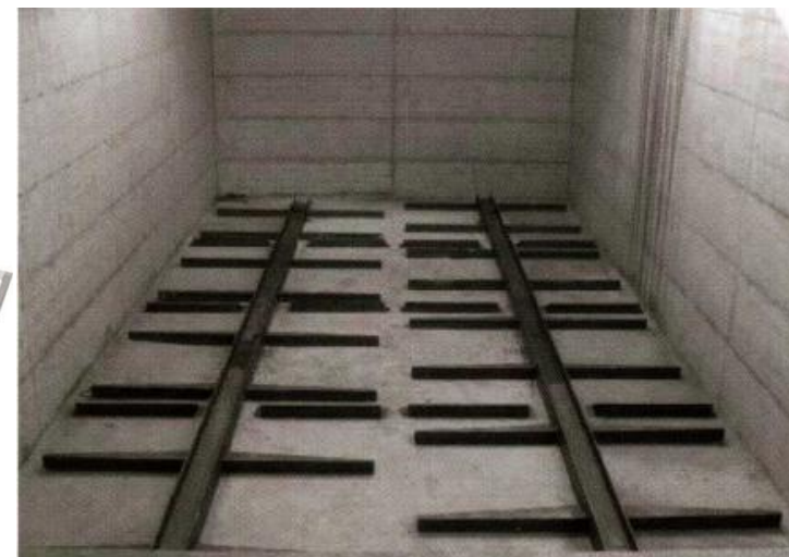
Горизонтальный бетонный силос объемом 20 500 м 3 . Размер движущихся полов – 2 м (Ш) x 4 12 м (Д) x 4 м (В)
