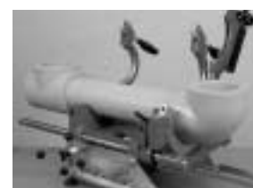
готовая сварка после охлаждения
